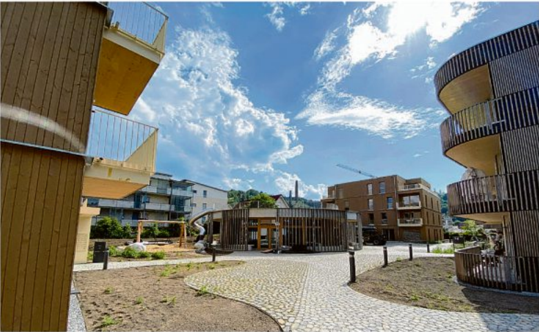
Die Hoffnungshäuser in Gaildorf werden derzeit bezogen. Ein paar Arbeiten an den Außenanlagen werden noch ausgeführt.
